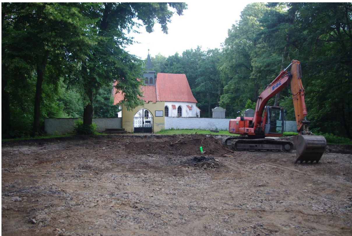
Obr. 4: plocha výzkumu po odstranění asfaltu a podsýpek.
